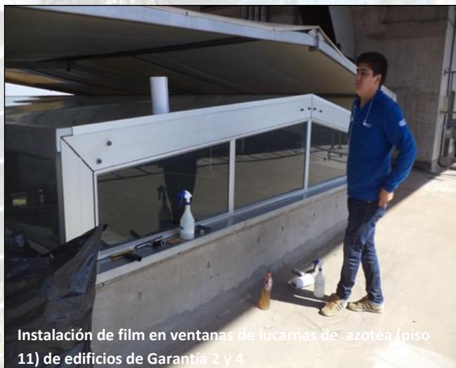
Instalación de film en ventanas de lucarnas de azotea (piso 11) de edificios de Garantía 2 y 4
